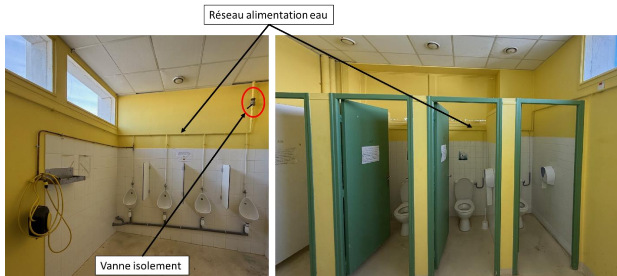
Figure 13 : alimentation en eau des WC + urinoirs
