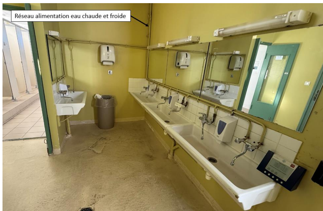
Figure 16 : réseau alimentation eau chaude et froide lavabos
