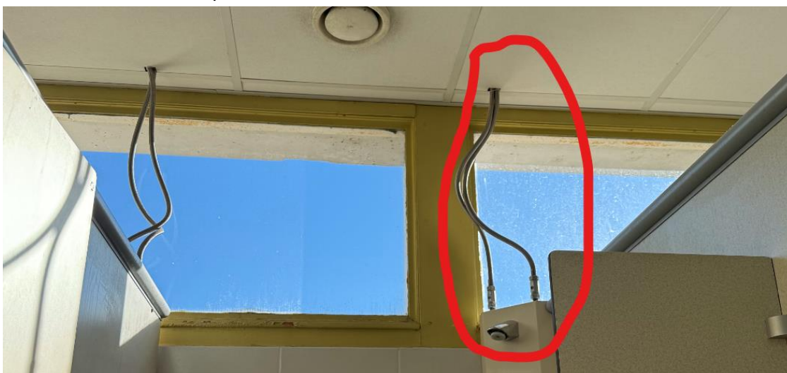
Figure 10 : alimentation eau chaude et froide des douches
