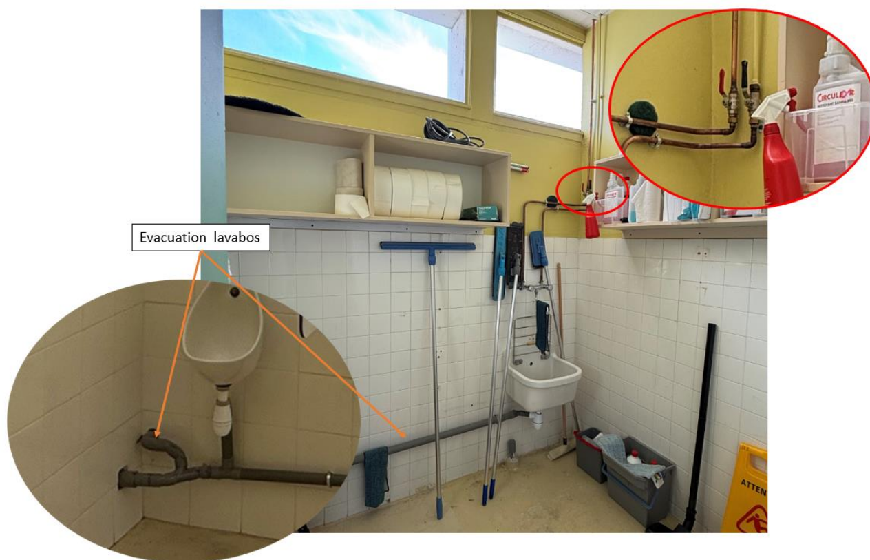
Figure 21 : Alimentations et évacuation lavabo entretien
